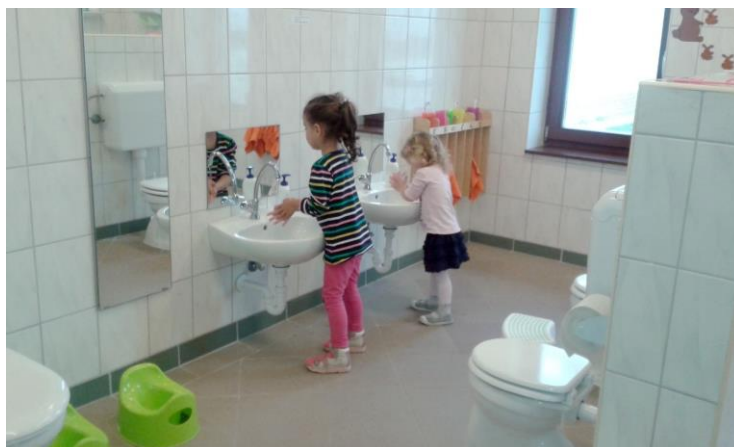
20. kép. A gyermekfürdőszoba berendezése (Forrás: Szigetmonostori Bölcsőde, 2017).
